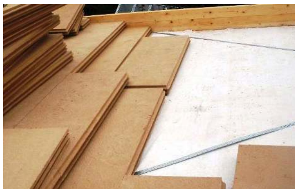
Foto 1, 2) Celoobvodový střešní rám na pultové střeše, připevnění pomocí zavětrovacích pásek do krokví
