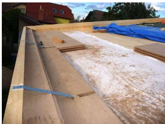
Foto 1, 2) Celoobvodový střešní rám na pultové střeše, připevnění pomocí zavětrovacích pásek do krokví
