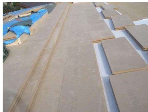
Foto 1, 2) Celoobvodový střešní rám na pultové střeše, připevnění pomocí zavětrovacích pásek do krokví
