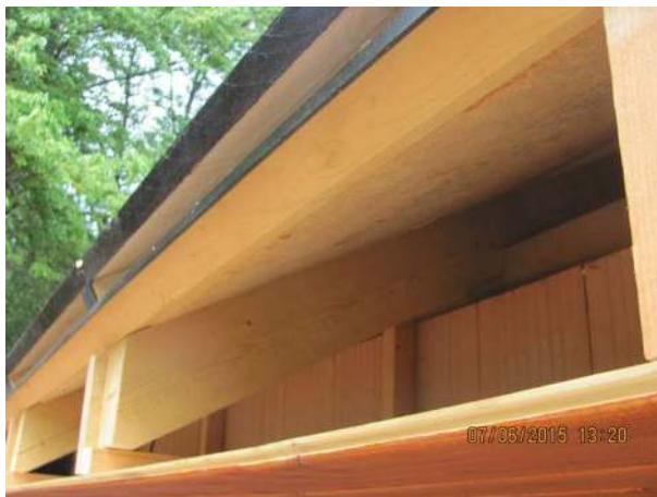
Obr. 3) Dřevěný hranol podél okapu vytvoří rovnou linii pro položení první řady desek
