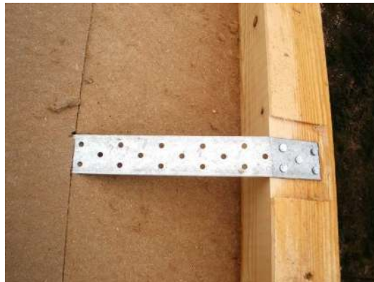
Foto 1, 2) Celoobvodový střešní rám na pultové střeše, připevnění pomocí zavětrovacích pásek do krokví
