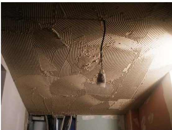
Obr. 6A, 6B : omítkové souvrství TERMO+ diffu, postup mokrý na suchý
