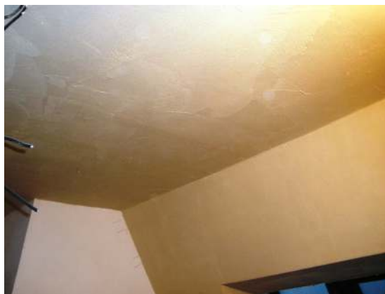
Obr. 6A, 6B : omítkové souvrství TERMO+ diffu, postup mokrý na suchý
