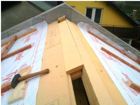
Obr. 7) Ukončení desek u hřebene
