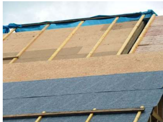
Obr. 10) Přesah střechy u štítu
