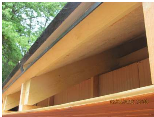
Obr. 5) Založení desky Pavatex u okapu
