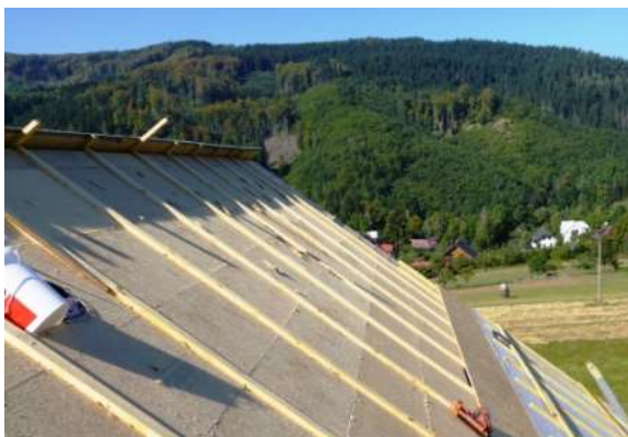
Obr. 9) Plošné zakrytí sedlové střechy
